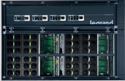
ARCHIMOD HE 160 Potência: 160 kW (escalável até 240 kW) 01 x Frame de distribuição 24 x Módulos de potência 6,7 kW 04 x Kit cover para módulo de potência
