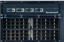
ARCHIMOD HE 240 Potência: 240 kW 01 x Frame de distribuição 36 x Módulos de Potência
